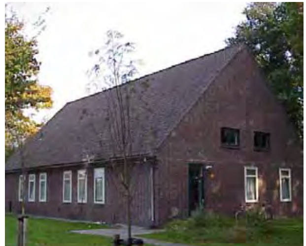
aangetast door onpassende kozijnen
