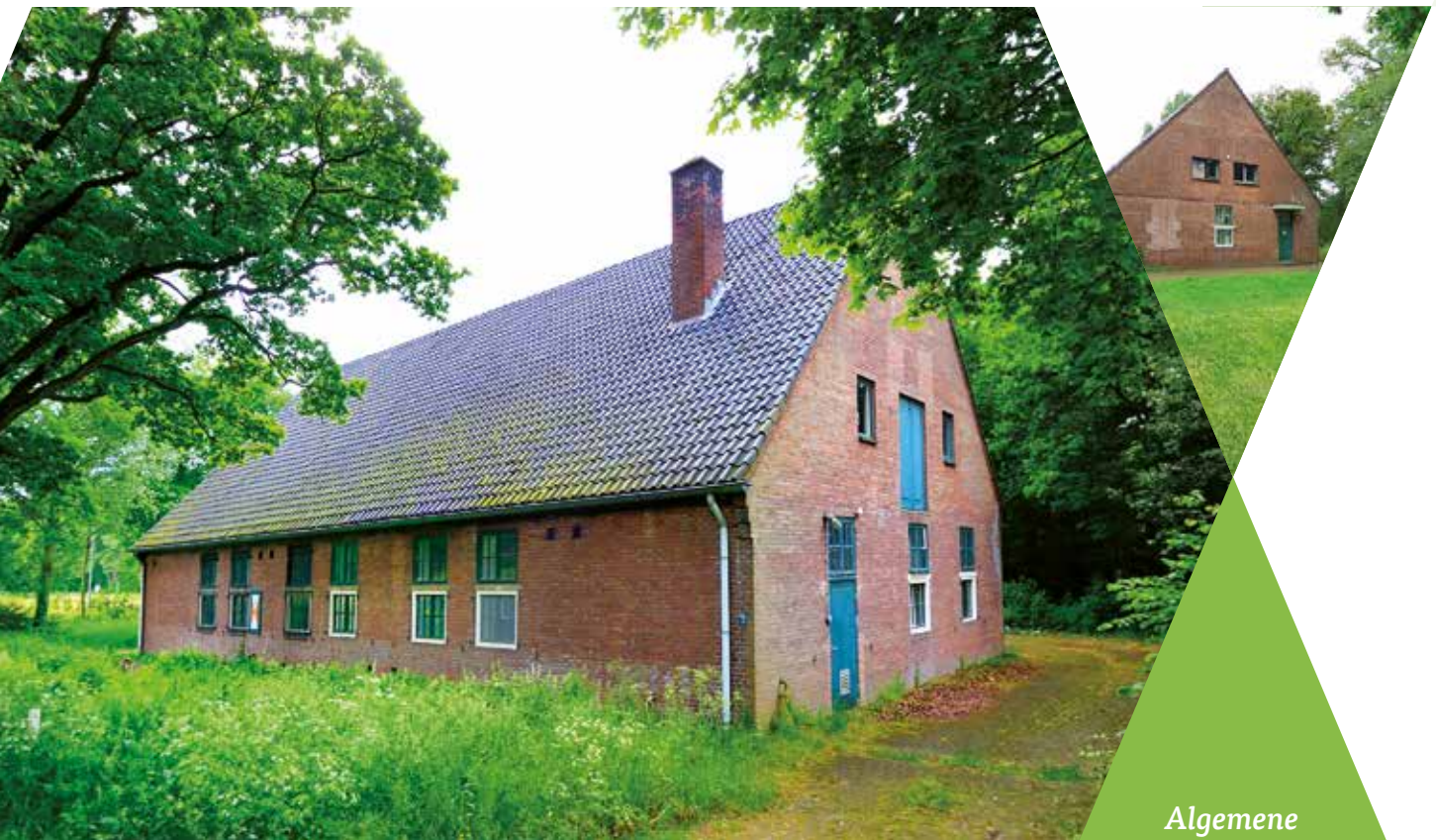
Pand voor verbouw
