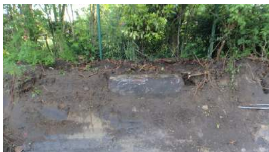
Foto 5: aangetroffen tank op perceelsgrens
