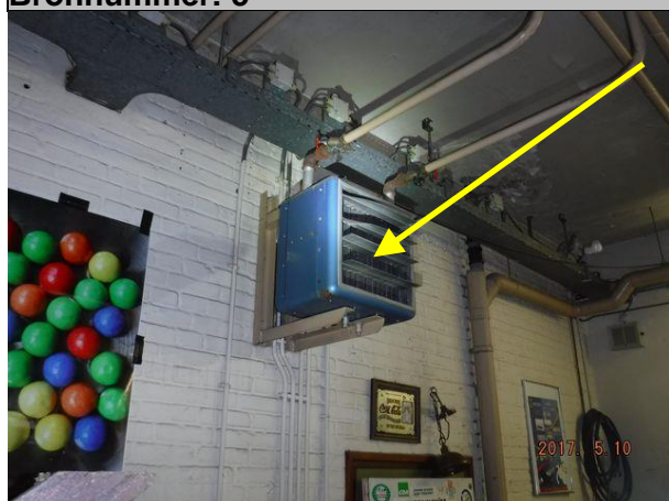
Asbestverdachte Heater, type en bouwjaar onbekend
