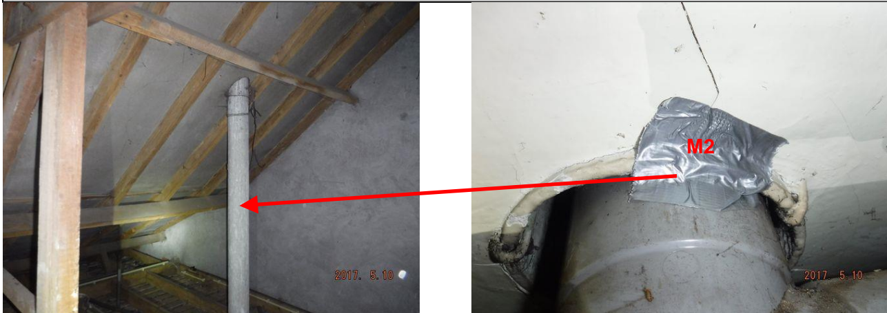
Buis op zolder van gebouw Z87
