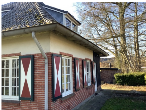
Buitenzijde van de woning
