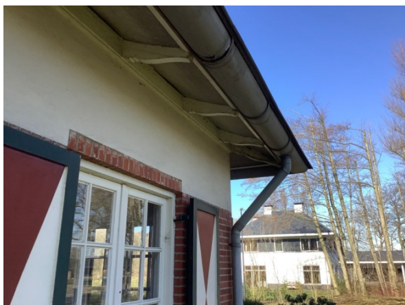
Buitenzijde van de woning
