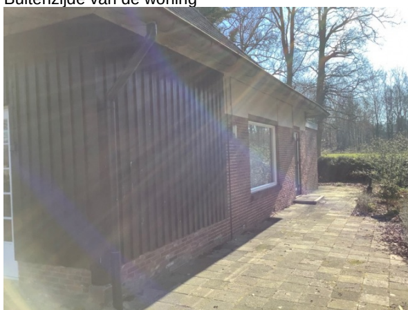
Buitenzijde van de woning
