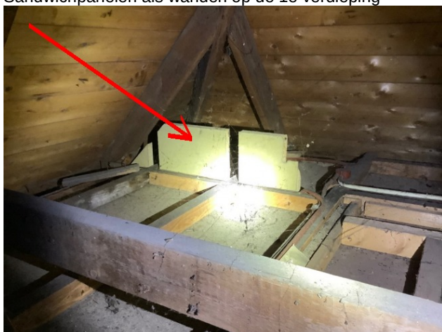
Sandwichpanelen als wanden op de 1e verdieping
