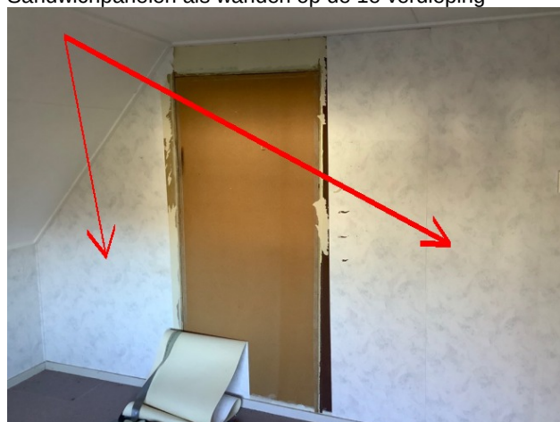
Sandwichpanelen als wanden op de 1e verdieping
