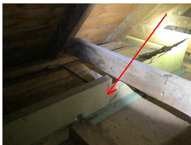
Sandwichpanelen als wanden op de 1e verdieping
