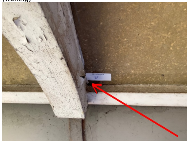
Vlakke platen aan de overstekken van gebouw Z43a (woning)
