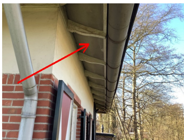
Vlakke platen aan de overstekken van gebouw Z43a (woning)
