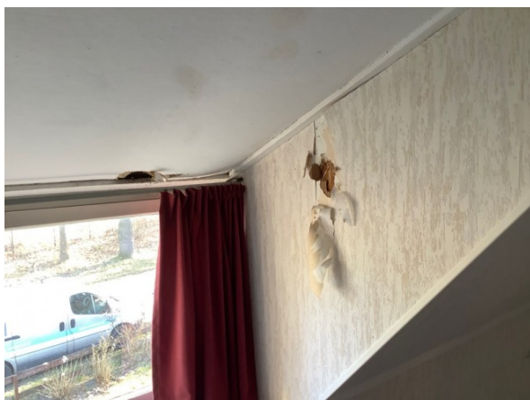
1e verdieping van de woning
